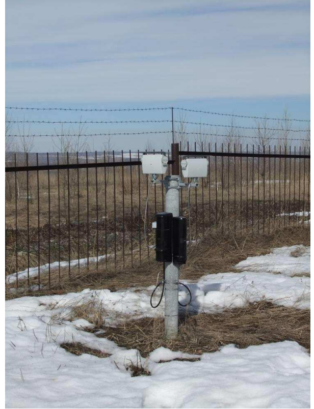
Рисунок 2 – Внешний вид установки извещателей
