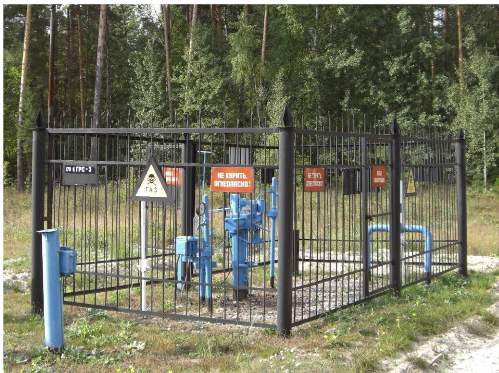
Рисунок 1 - Пример КП с линейными размерами 3x5м
