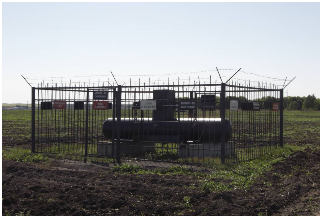
Рисунок 6 - Пример КП с металлической радионепрозрачной конструкцией
