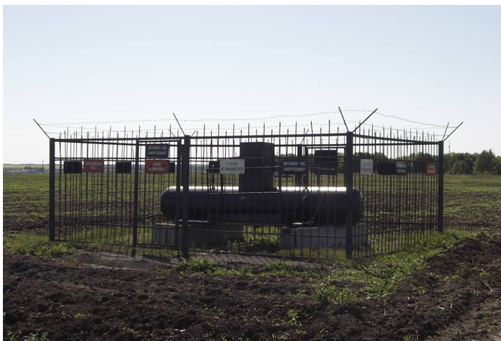
Рисунок 8 - Пример КП с металлической радионепрозрачной конструкцией
