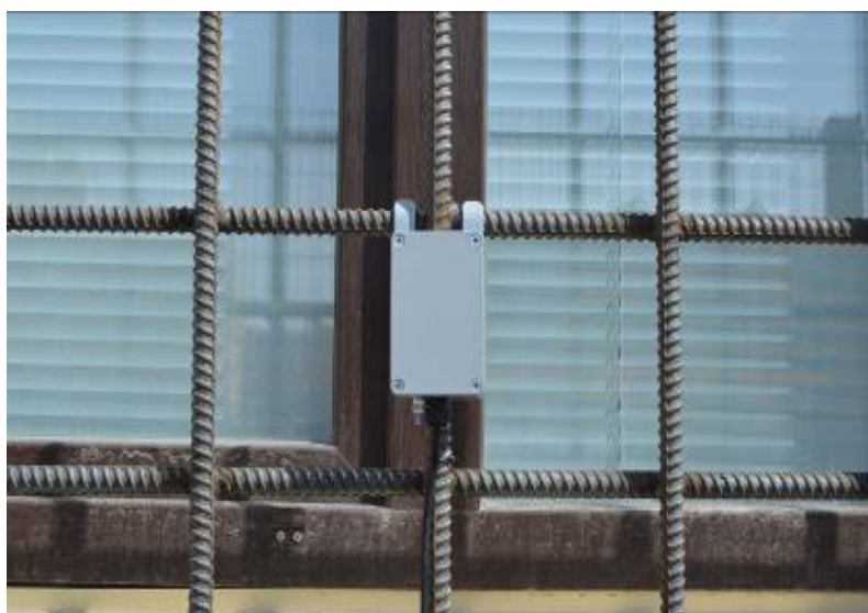
Рисунок 18 – Блокирование оконной решетки
