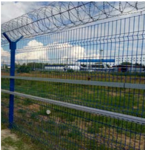
Рисунок 5 – Крепление ДВ на нижней секции полотна ограждения
