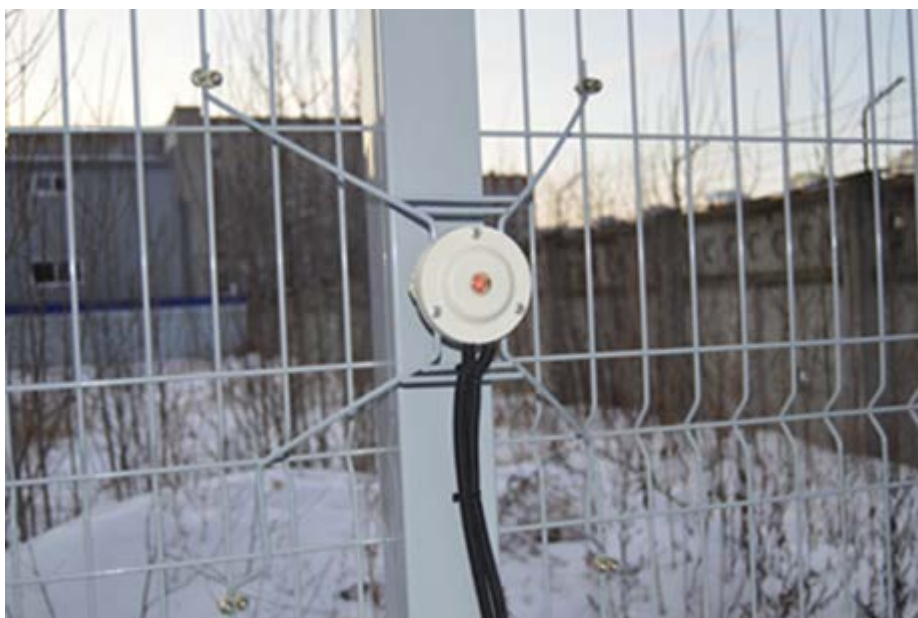
Рисунок 6 – Установка ДВ на соединитель секций
