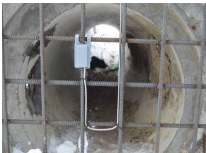
Рисунок 15- Установка ДВ-Г на решетке водоотпуска
