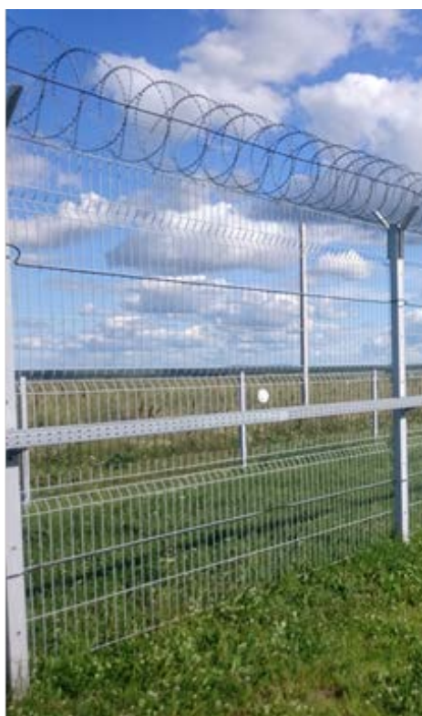
Рисунок 4 – Установка ДВ на панель секции ограждения
