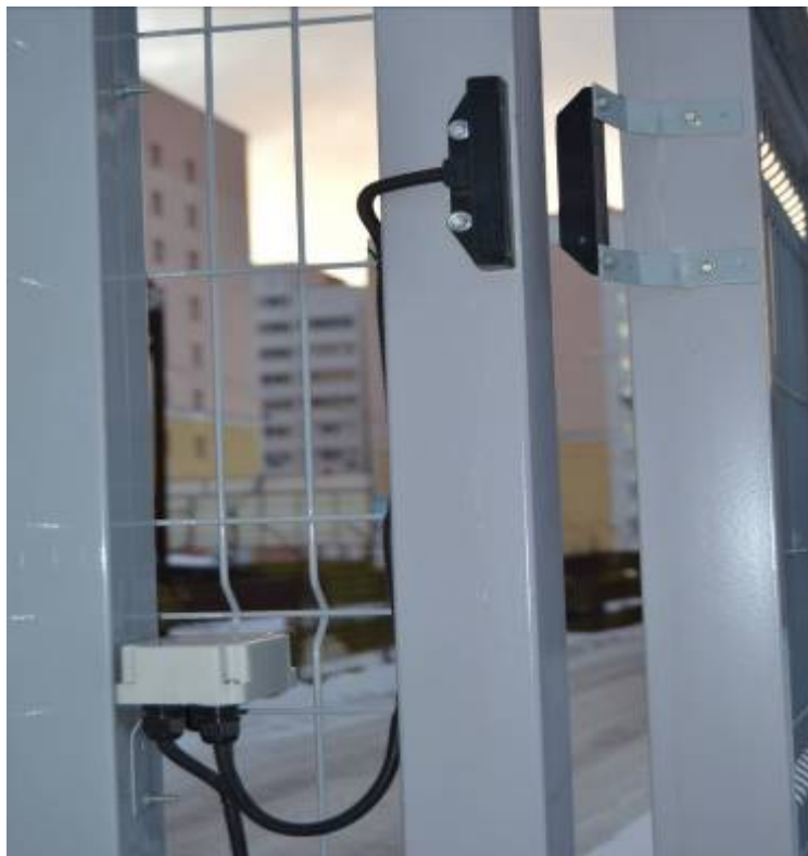
Рисунок 23 – Подключение к БК-ШС магнитоконтактного извещателя
