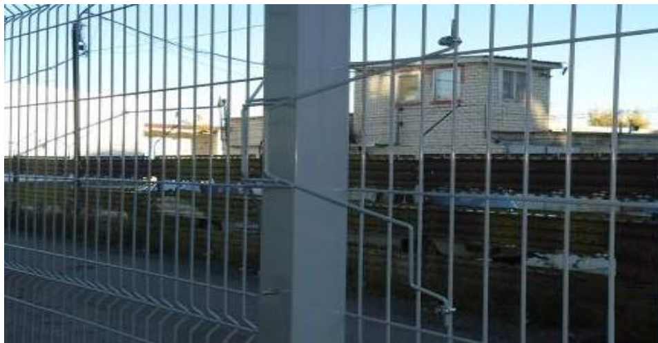
Рисунок 7 – Соединитель секций
