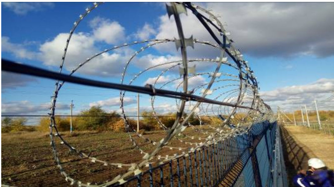
Рисунок 11 – Крепление трибокабеля
