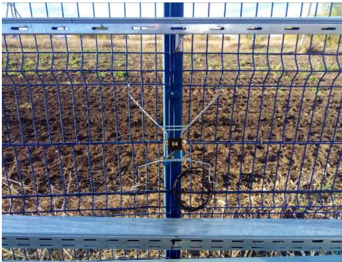
Рисунок 6 – Крепление ДВ-ЛВЧ на соединителе секций
