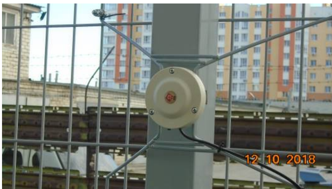
Рисунок 5 – Крепление ДВ на соединителе секций
