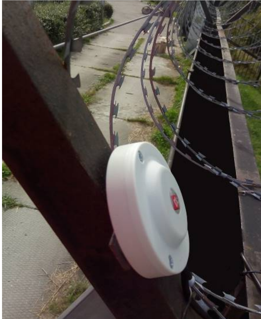
Рисунок 10 – Крепление ДВ на кронштейне АКЛ
