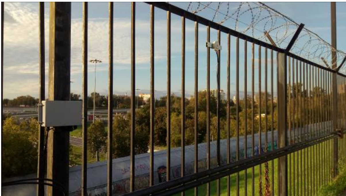
Рисунок 8 – Крепление ДВ на кованном ограждении
