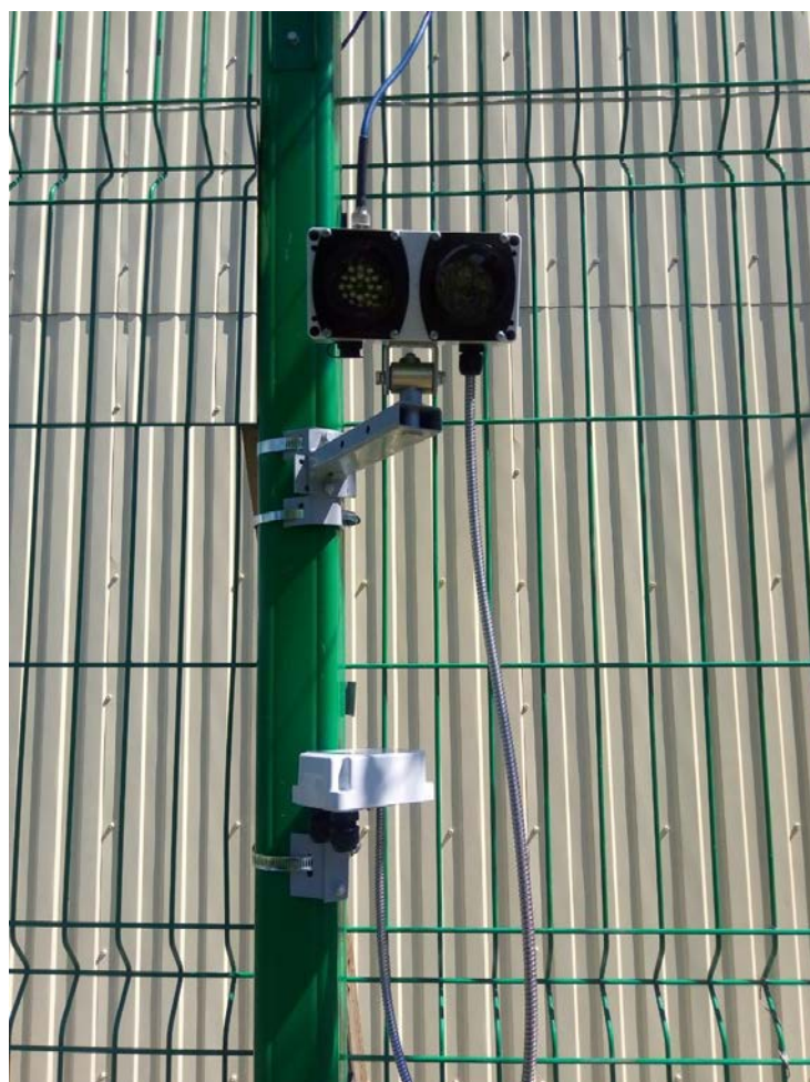
Рисунок 6 – Крепление МВР-Р на опоре заграждения
