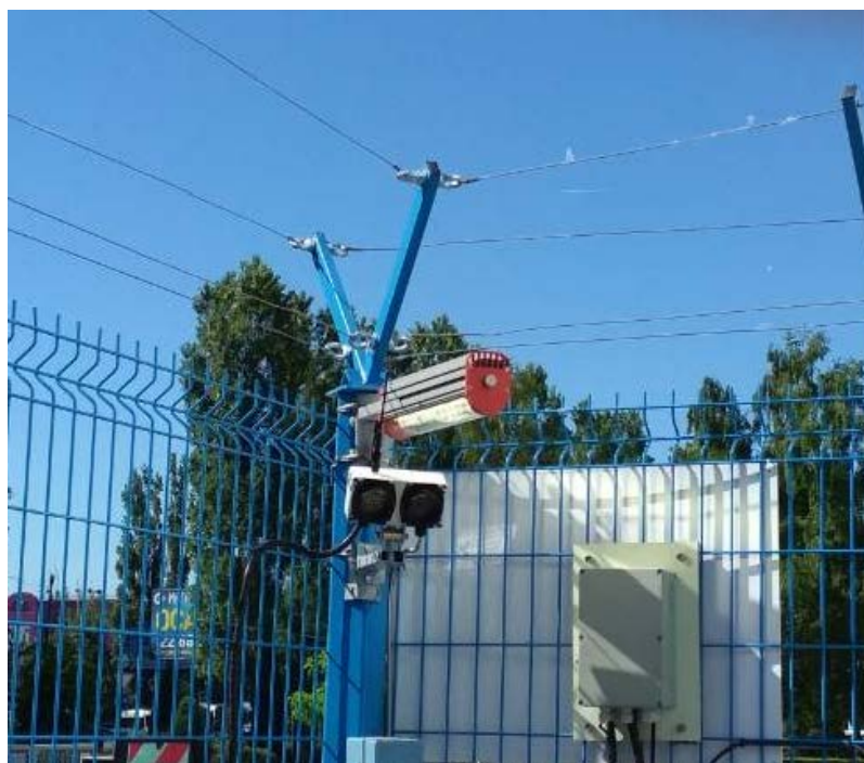
Рисунок 5 – Крепление МВР-Р на заграждении типа «Махаон-Стандарт»
