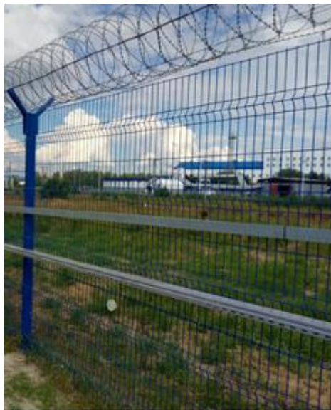
Рисунок 5 – Крепление ДВ на нижней секции полотна ограждения
