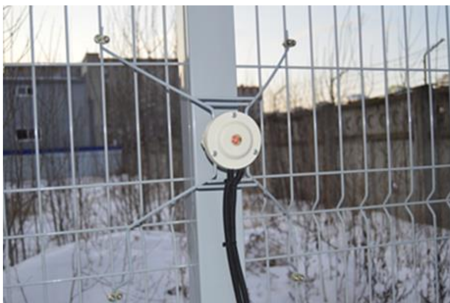
Рисунок 6 – Установка ДВ на соединитель секций
