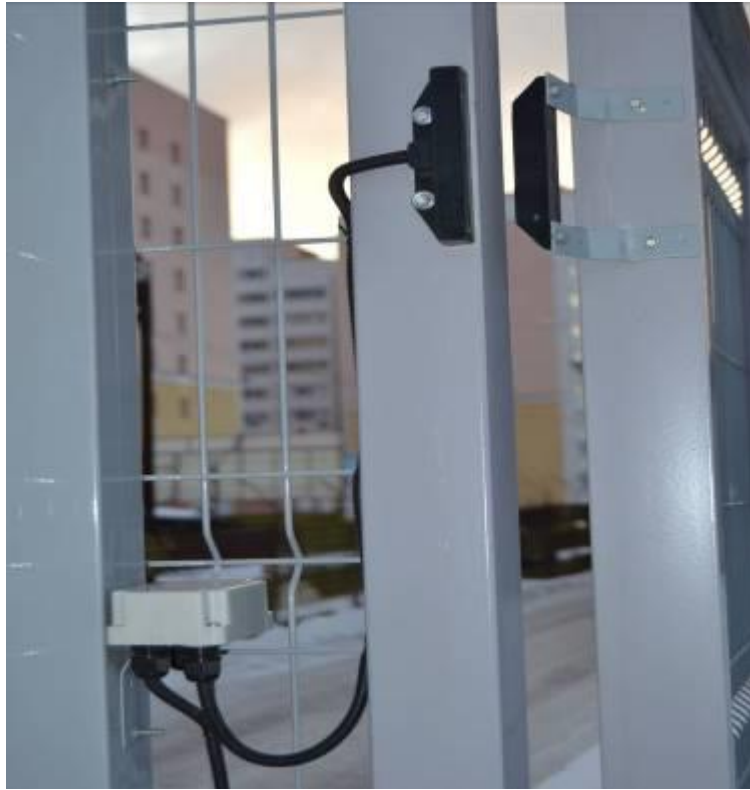
Рисунок 23 – Подключение к БК-ШС магнитоконтактного извещателя
