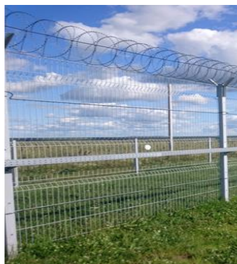
Рисунок 4 – Установка ДВ на панель секции ограждения
