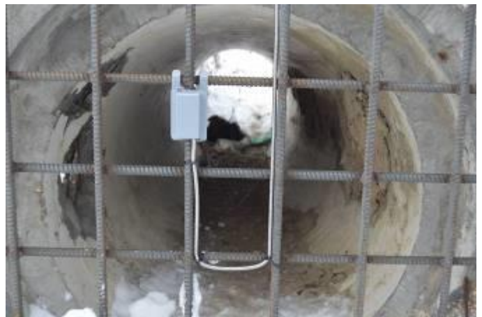
Рисунок 15- Установка ДВ-Г на решетке водоотпуска.
