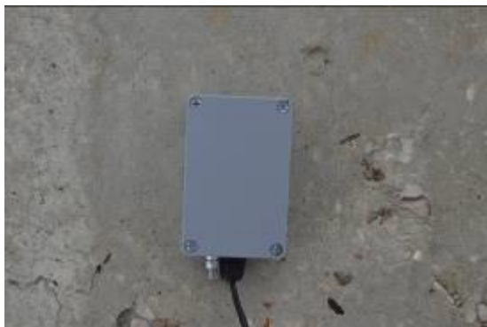
Рисунок 19 – Установка ДВ на бетонном ЗГР
