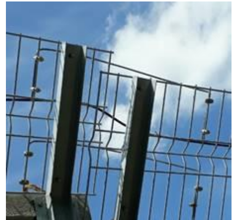
Рисунок 17 – Соединитель секций из арматуры
