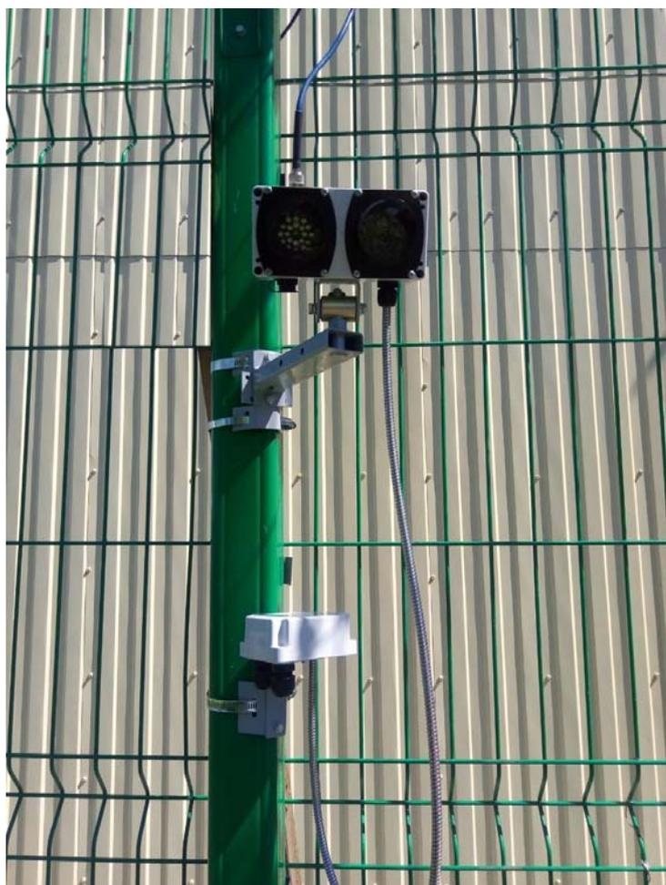
Рисунок 6 – Крепление МВР-Р на опоре заграждения
