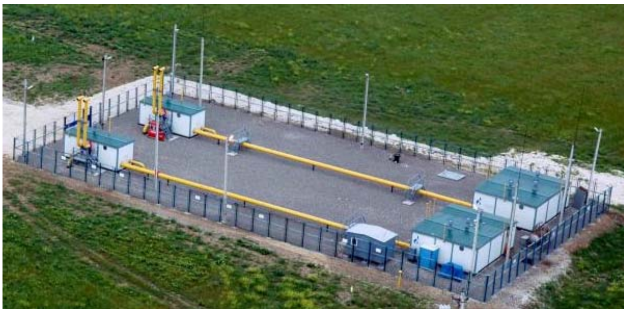
Рисунок 1 – Пример объекта ГРС
