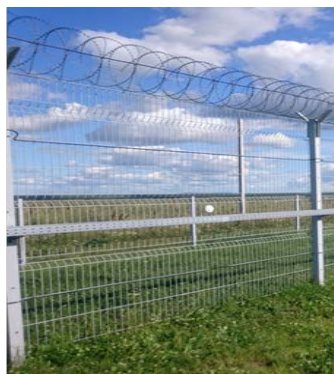
Рисунок 4 – Установка ДВ на панель секции ограждения
