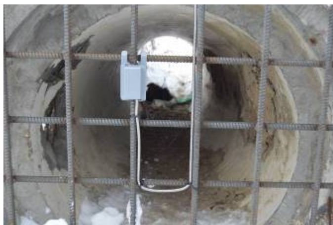
Рисунок 15- Установка ДВ-Г на решетке водоотпуска
