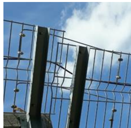
Рисунок 17 – Соединитель секций из арматуры
