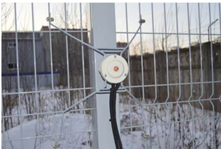
Рисунок 6 – Установка ДВ на соединитель секций
