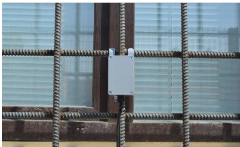
Рисунок 18 – Блокирование оконной решетки
