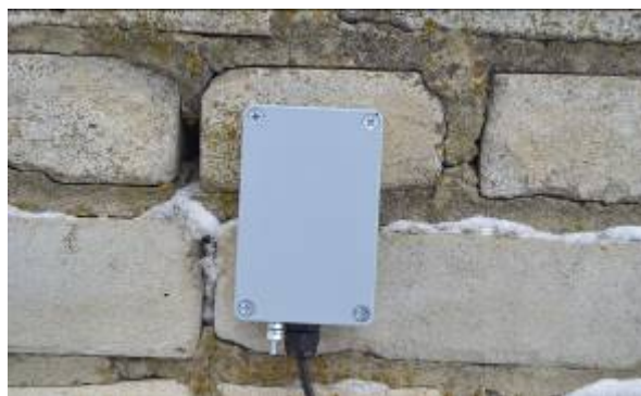
Рисунок 20 – Установка ДВ-ИО на кирпичном ЗГР
