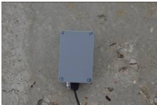
Рисунок 19 – Установка ДВ-ИО на бетонном ЗГР
