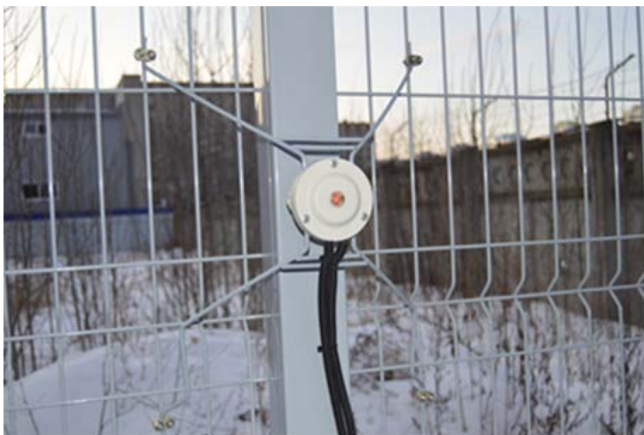
Рисунок 6 – Установка ДВ на соединитель секций
