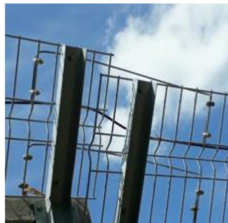
Рисунок 17 – Соединитель секций из арматуры
