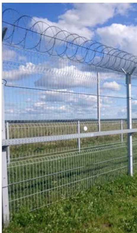
Рисунок 4 – Установка ДВ на панель секции ограждения
