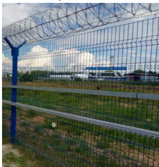
Рисунок 5 – Крепление ДВ на нижней секции полотна ограждения
