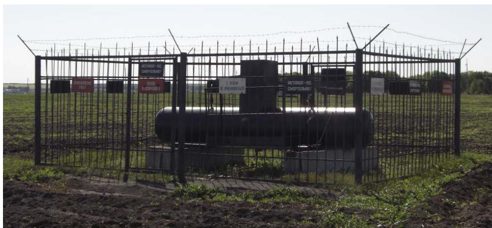
Рисунок 2 - Пример площадки со сварным решетчатым ограждением
