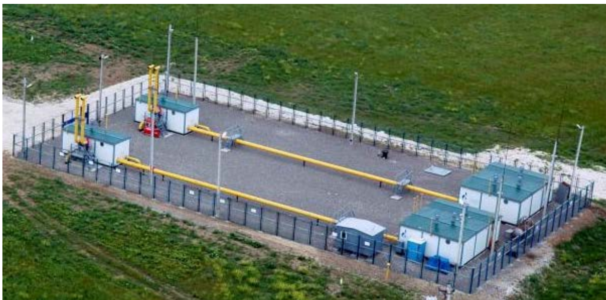
Рисунок 1 – Пример объекта ГРС
