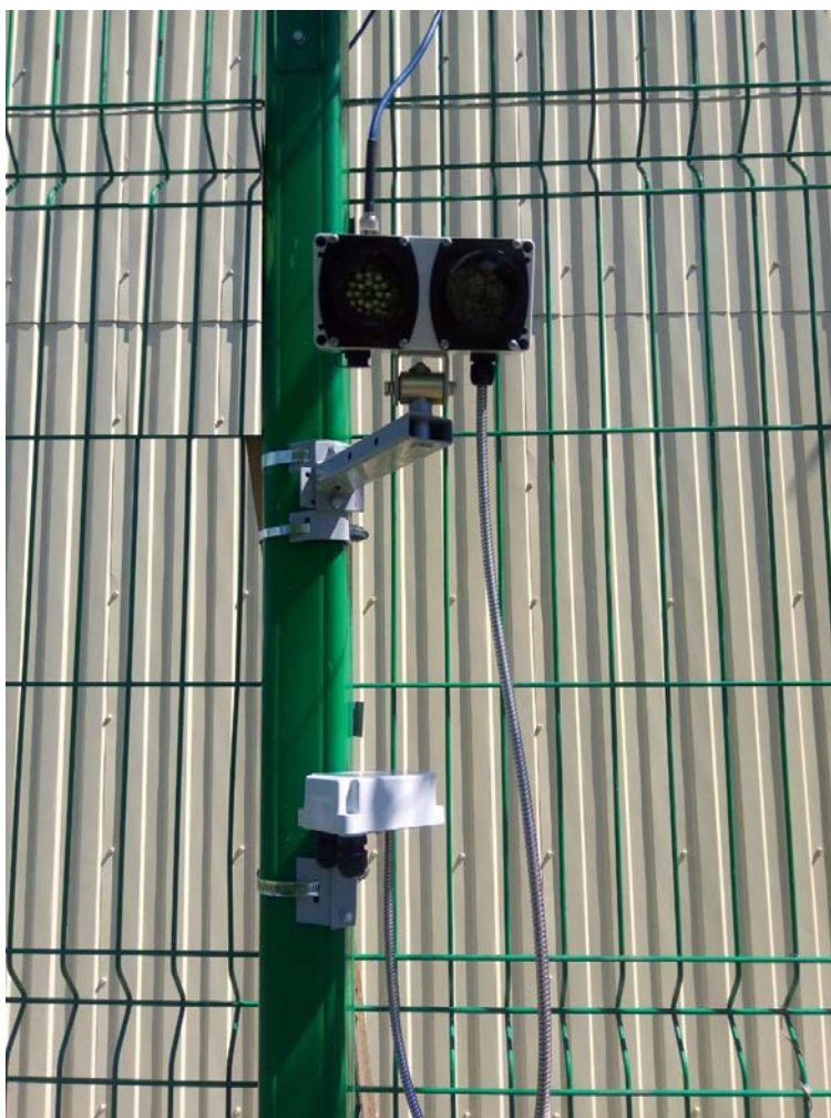
Рисунок 7 – Крепление МВР-Р на опоре заграждения
