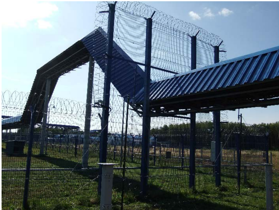
Рисунок 6 -Установка блоков ДПР-10В на подборной опоре при охране кабельной эстакады.
