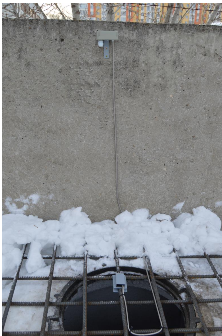
Рисунок 2- Установка ДВ-ИО-Г на решетке
